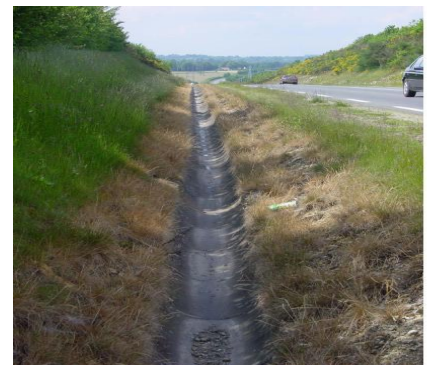
Traitement du caniveau à côté de la rivière
