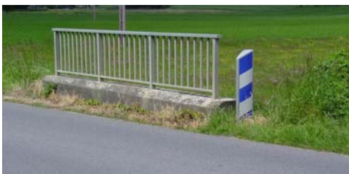
Désherbage à côté d'un pont en prise d'eau en rivière
